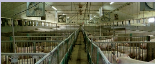
Gros ventilateurs de recirculation d'air dans une gestation en toit cathédrale (Ferme Vi-Ber inc.).
